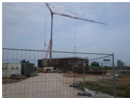
Az épülő tisztítómű
