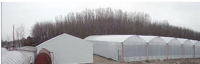
Az új fóliablokk és a feldolgozó épület
